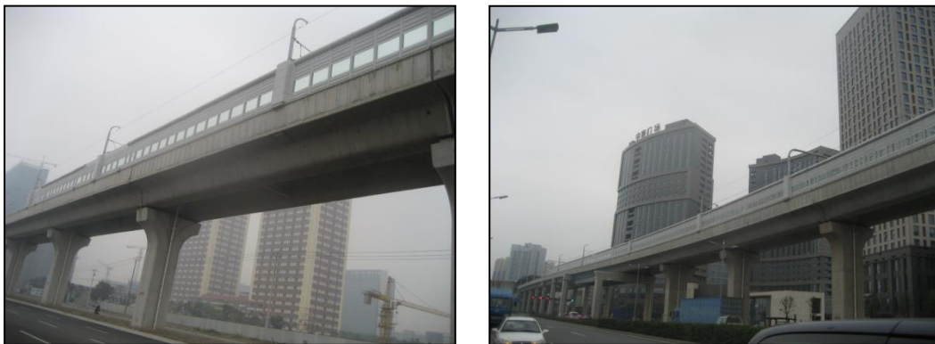
图 4.2-2 工程声屏障实施现状照片
